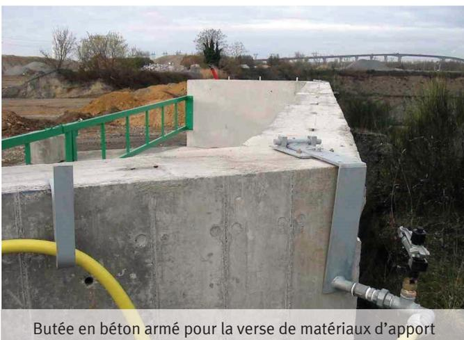
Butée en béton armé pour la verse de matériaux d'apport
