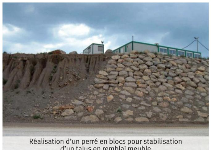
Réalisation d'un perré en blocs pour stabilisation d'un talus en remblai meuble
