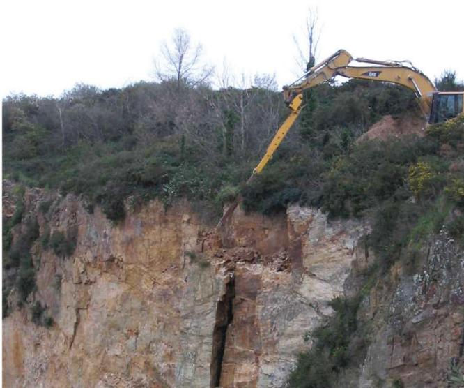
Opération de purge au brise-roche hydraulique sur pelle à chenilles
