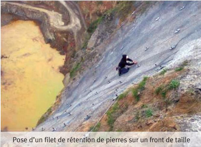
Pose d'un filet de rétention de pierres sur un front de taille
