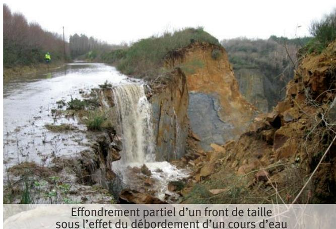
Effondrement partiel d'un front de taille sous l'effet du débordement d'un cours d'eau
