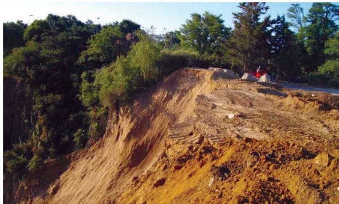
Plateforme de remblai instable
